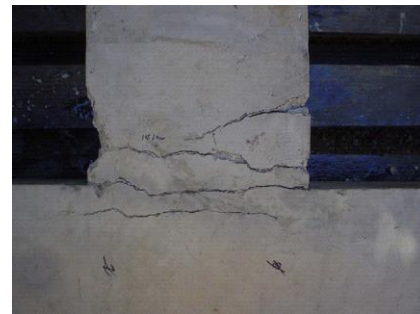
Fig.8(d) Failure pattern of CSF-T
